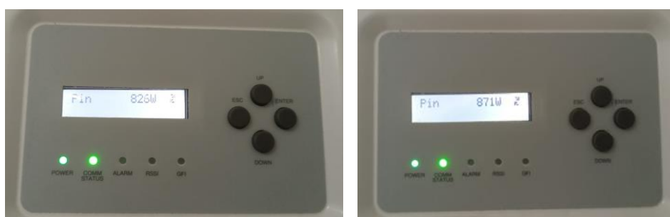
Figura 5 y 6, Imagen del valor de potencia instantánea de entrada del inversor correspondiente a la instalación con una capa de polvos y la otra en estado limpio respectivamente.
